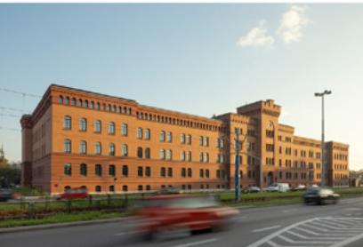
Budynek po rewitalizacji 2026 r.
