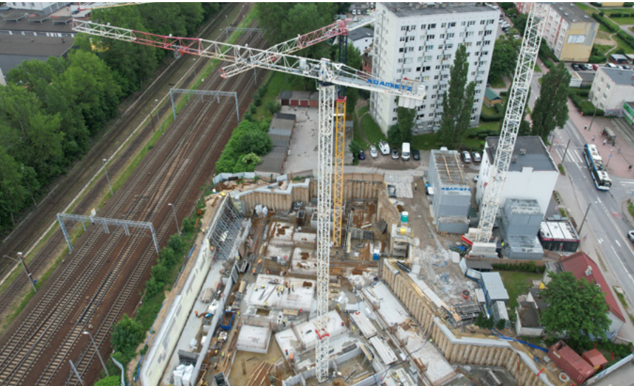
Budynek mieszkalny wielorodzinny Gdynia Nowa Chylonia, inwestor Marvipol
