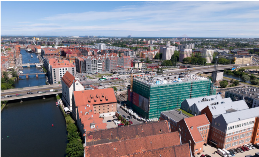
Widok z lotu ptaka na wkomponowaną w Motławę budowę hotelu Golden Tulip Gdańsk Old Town, inwestor Marvipol
